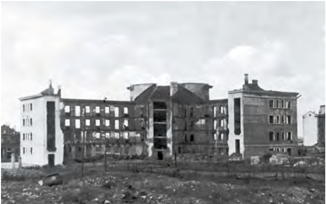
Вид на здание Министерства лесного хозяйства БССР на углу ул. К. Маркса и Комсомольской в г. Минске, разрушенное в годы Великой Отечественной войны (1944 г., АН 0-038496)
