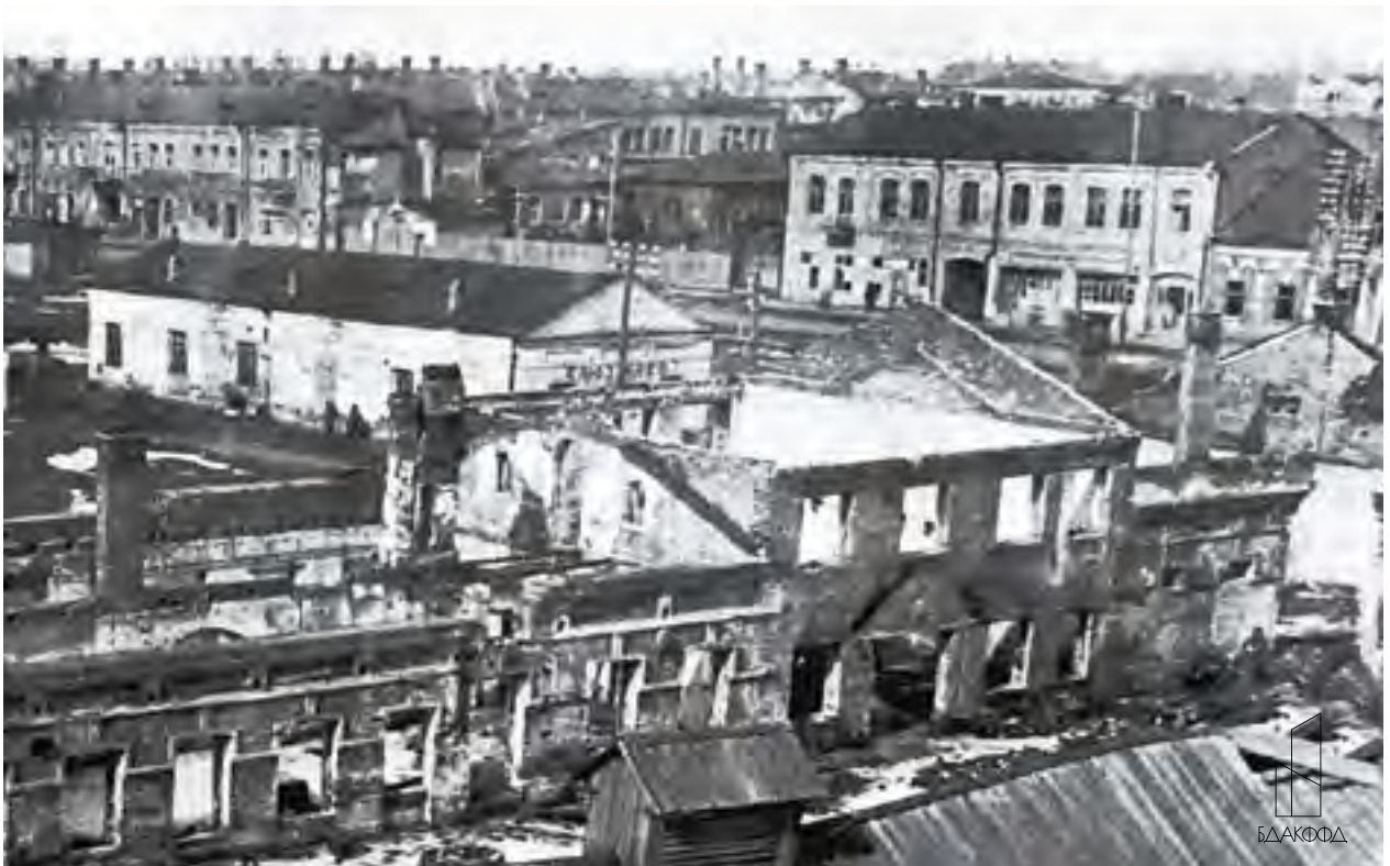
Разрушенные в годы Великой Отечественной войны жилые дома в г. Бобруйске (1941–1944 гг., АН 0-029614) Destroyed residential buildings in the city of Bobruisk during the Great Patriotic War (1941–1944, AN 0-029614)
