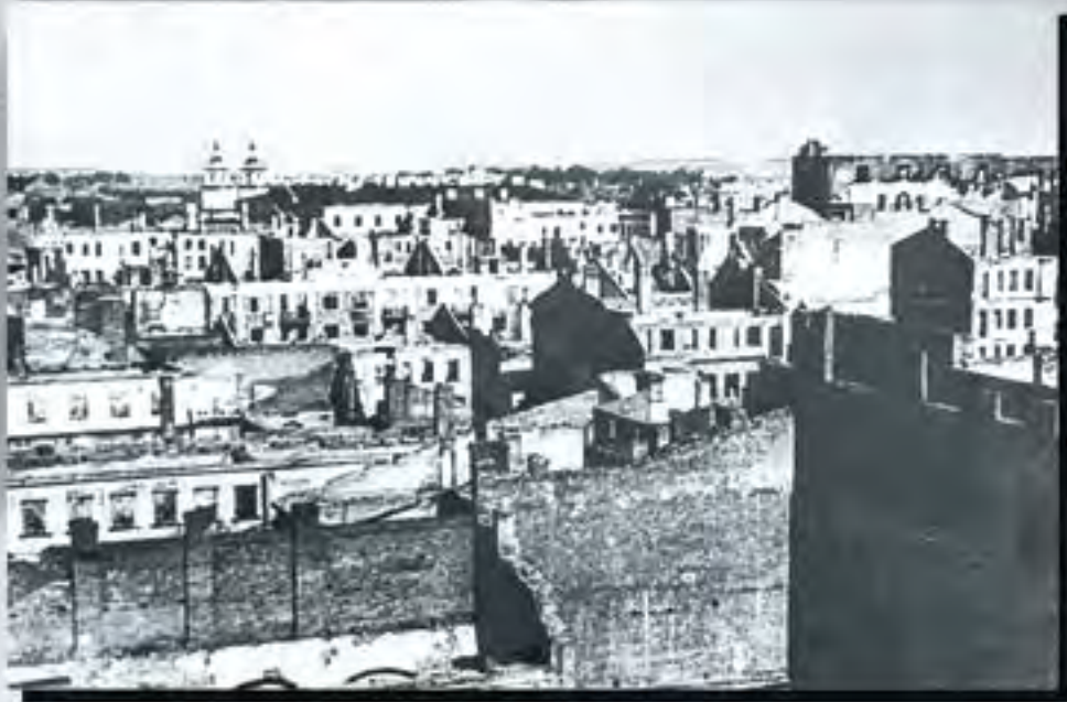
Разрушения в г. Минске.
